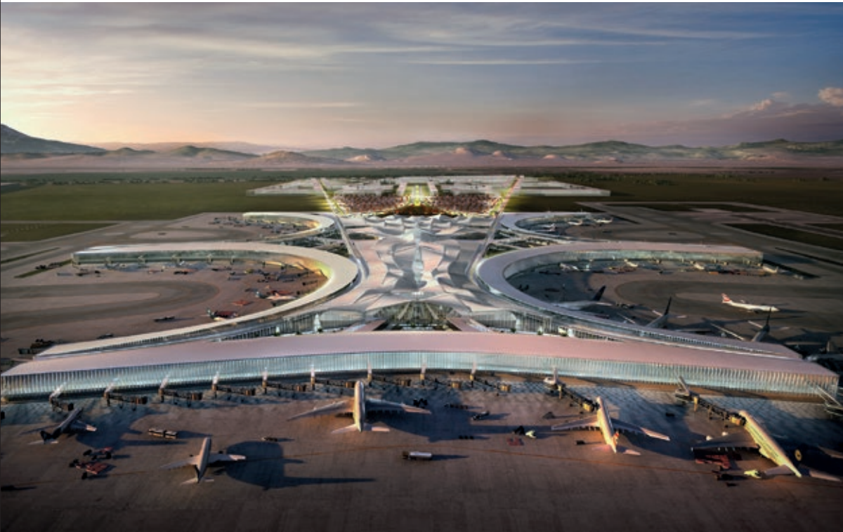
Nuevo Aeropuerto Internacional de la Ciudad de México—New International Airport Mexico City, 2014. Cortesía de—Courtesy of Zaha Hadid Architects, Render: Methanoia [Cat. 44]
